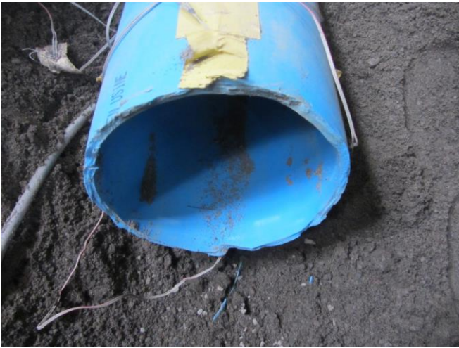
a) Pipe Side
